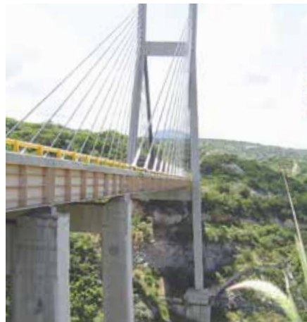
Barranca El Cañon Bridge México-Acapulco Highway
