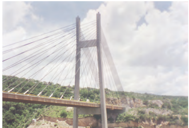
Barranca El Cañón Bridge, México-Acapulco Highway.
