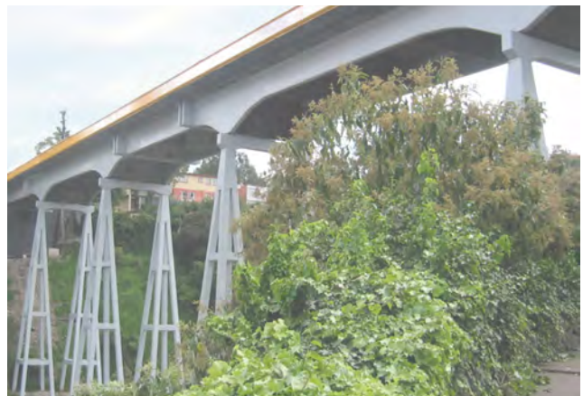
Puente "Monte Libano", Ciudad de México
