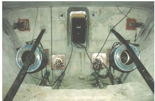
Viaducto "Metro Monterrey", Nuevo León.
