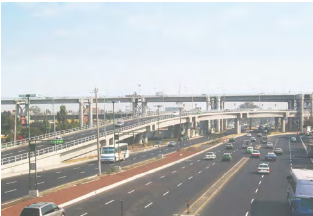
Distribuidor Vial "Zaragoza", Cd. de México
