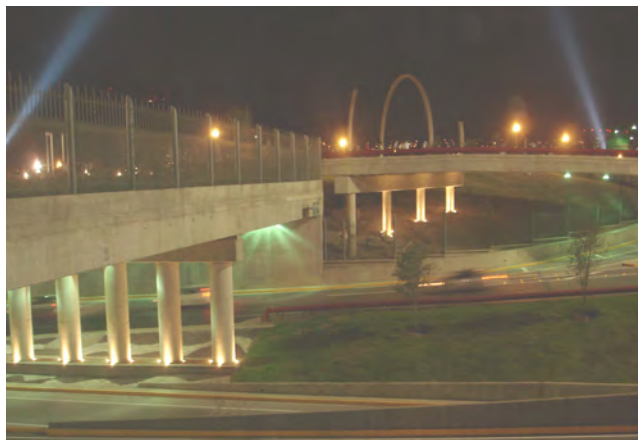
Puente Canal "Santa Lucía", Monterrey, N.L.
