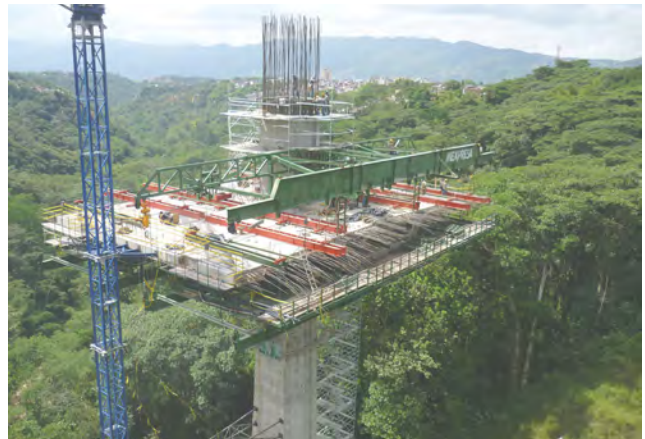
Viaducto Carrera Novena, Bucaramanga, Colombia
