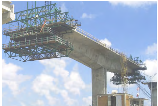
Puente GIWW, Texas, USA
