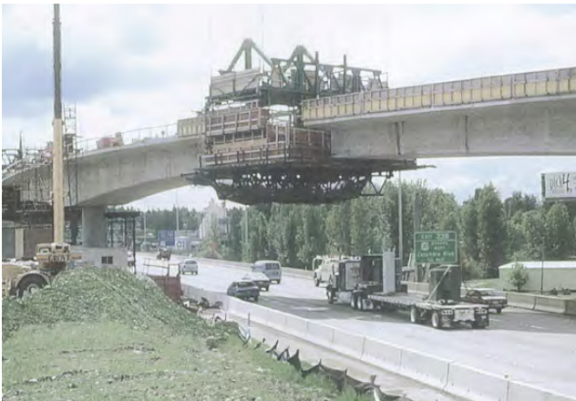
Puente "I-205", Pórtland, Oregon, U.S.A
