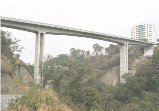
Puente "Lomas Country IV", Edo. Estado de México
