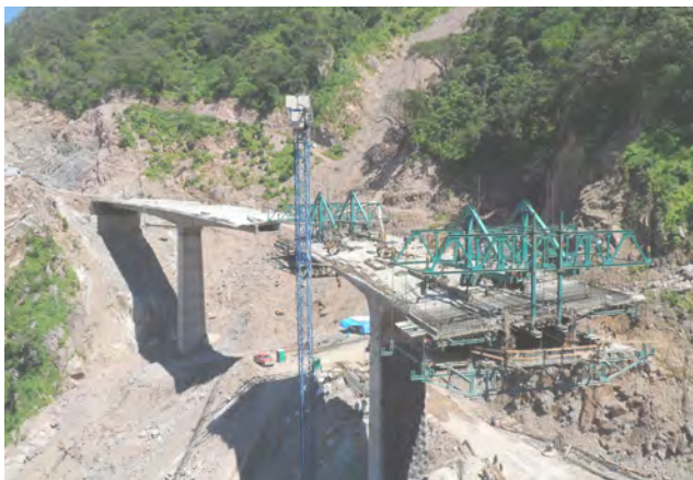
Puente Platanito, Carretera Durango-Mazatlán
