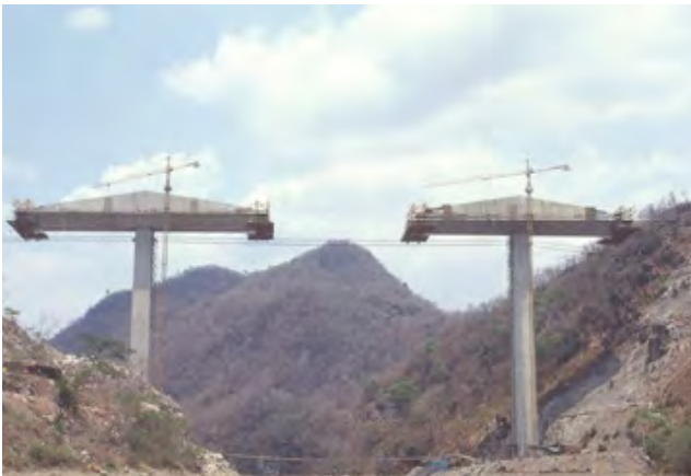
Puente "Papagayo", Autopista México - Acapulco
