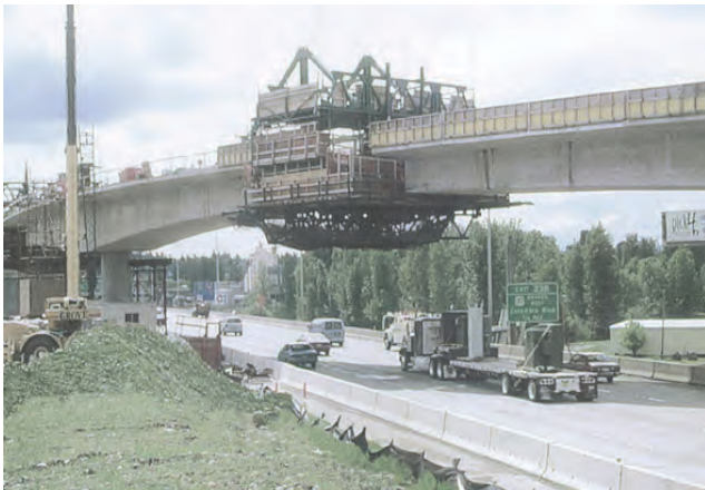
Puente "I-205", Pórtland, Oregon, U.S.A
