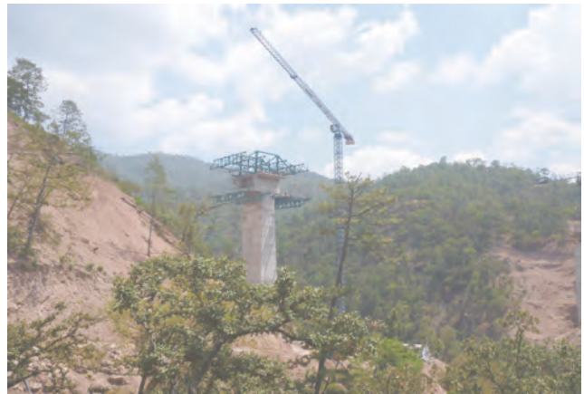
Pueblo Nuevo Bridge, Durango -Mazatlán Highway
