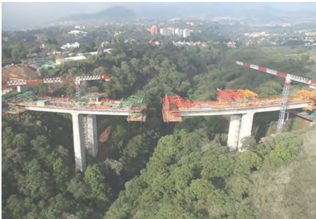
Bridge # 1, Supervía Poniente, México City
