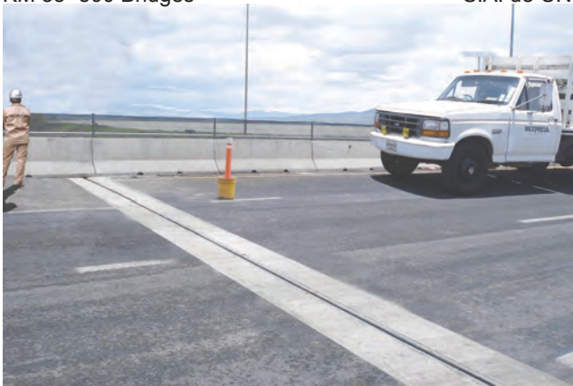
Circuito Exterior Mexiquense
