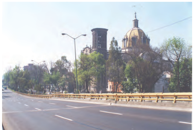
Juan Escutia Bridge, México, D.F
