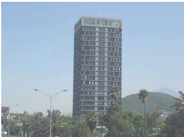
Edificio "Horizontes Díaz Ordaz", Monterrey, Nuevo León.
