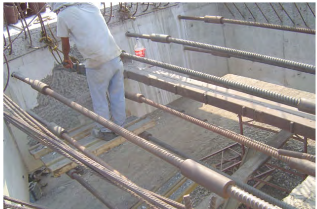
Puente Albatros, Lázaro Cárdenas, Michoacán
