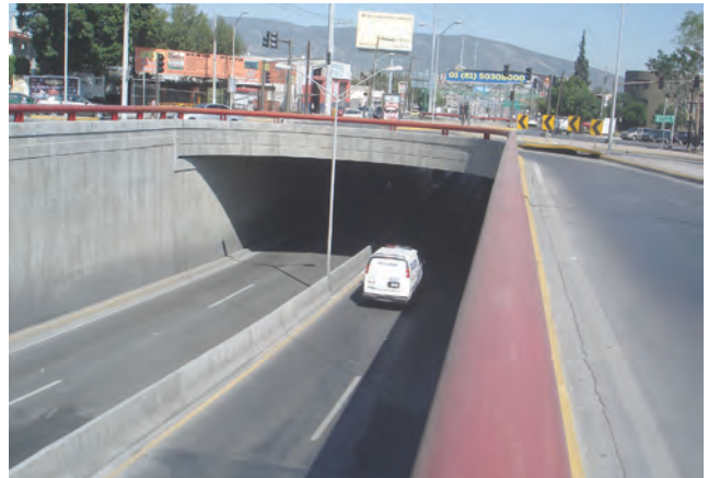
Rangel Frías & Av. Gobernadores Bridge, Monterrey, N.L.
