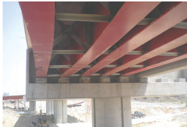
Pio X Bridge, Monterrey, N.L.
