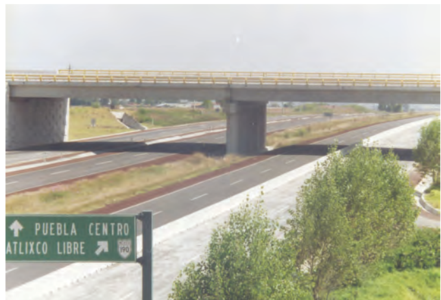
Atlixcayotl Bridge, Puebla, Puebla.
