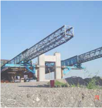
Puente Albatros Lázaro Cárdenas, Michoacán
