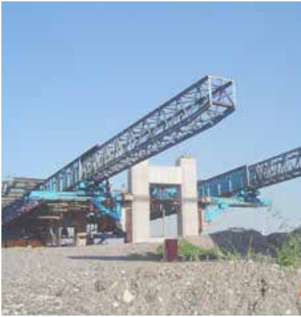
Albatros Bridge Lázaro Cárdenas, Michoacán
